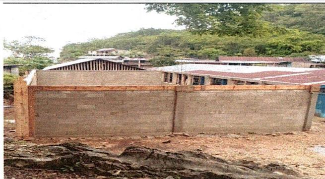
Foto 1: Colocacion de mojinete del aula de preprimaria, y luego la reparacion de pisos ceramicas dentro del salon de clase.
